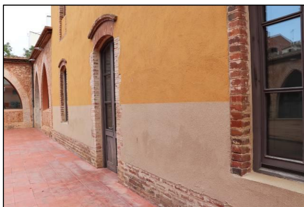
Figura 28 Recobrint amb suro projectat a la façana de l'edifici de l'organització
