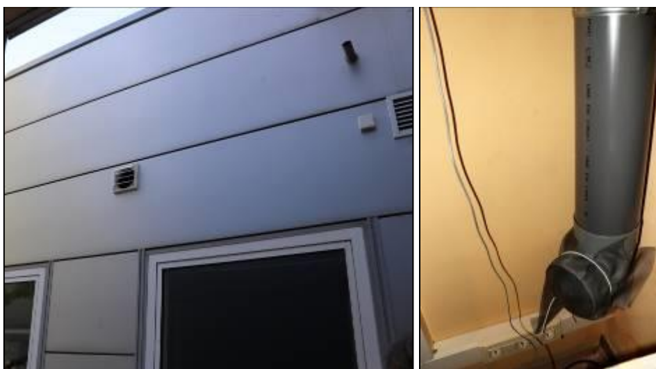
Figura 26 Sistemes de refredament d'aire mitjançant aire exterior
