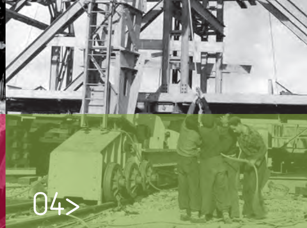
Montaje de una grúa del puerto de Ensidesa en Avilés (1955). Centro de Documentación. Arcelor-Mittal (Asturias)
